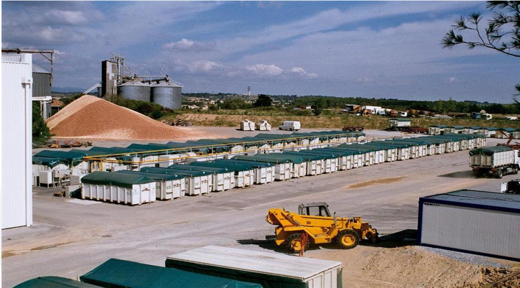
Übersicht Trocknungsanlagen mit Containern
