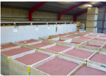
Bestehende Anlage für die Trocknung von behandeltem Saatgut in Kisten in 10 Abschnitte/Leitungen.
